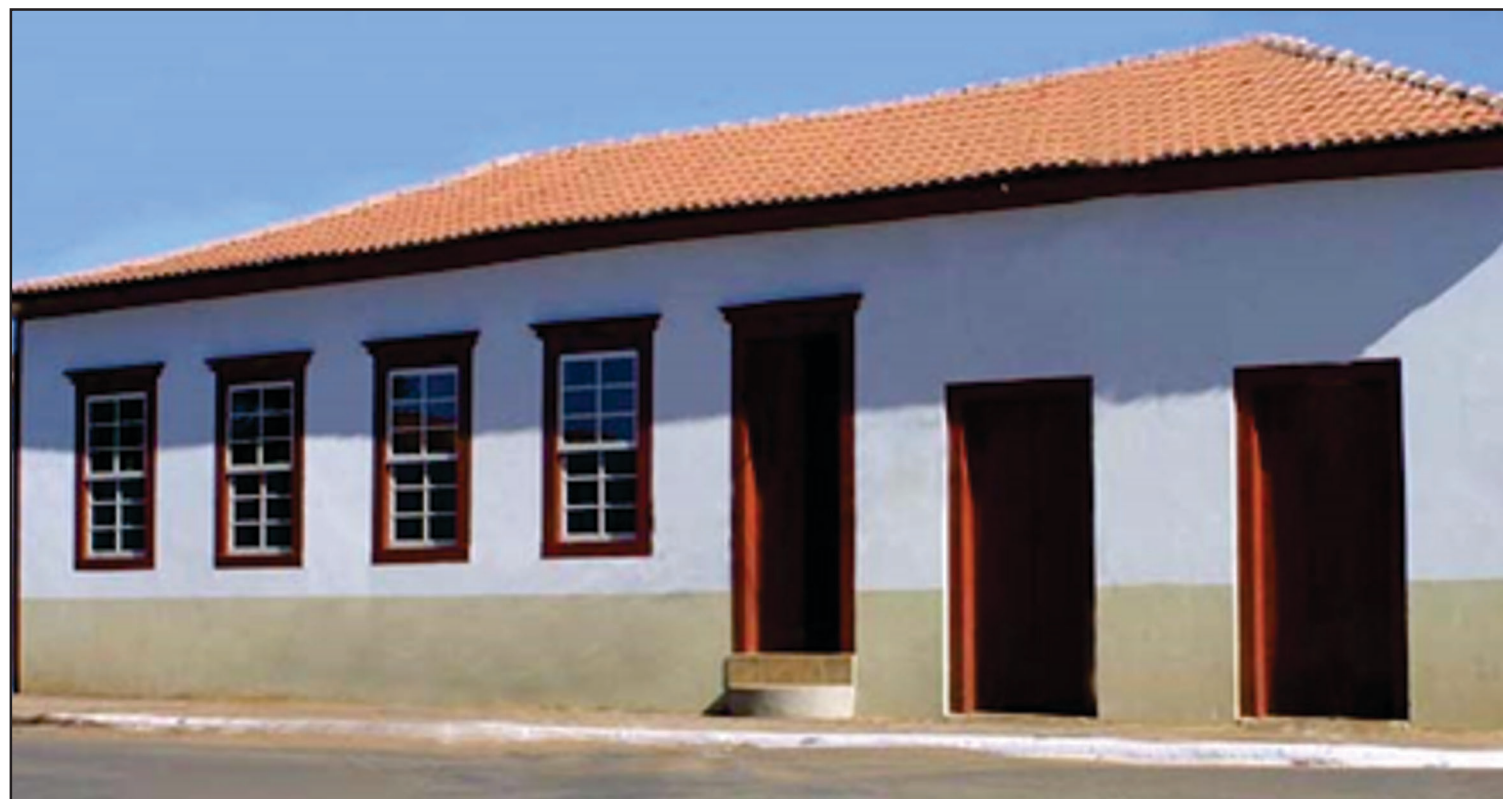
Casa do seo Valtinho, recentemente demolida, será reconstruída utilizando-se a técnica de retrofit e abrigará um empreendimento comercial
