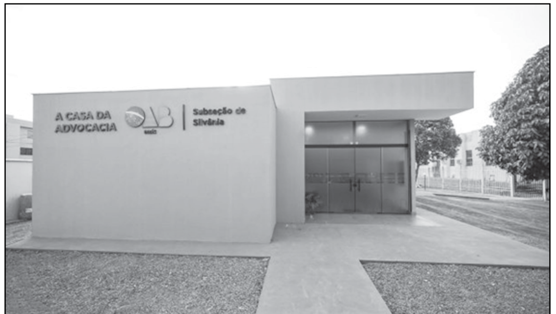
... e também a renovação da fachada e comunicação visual
