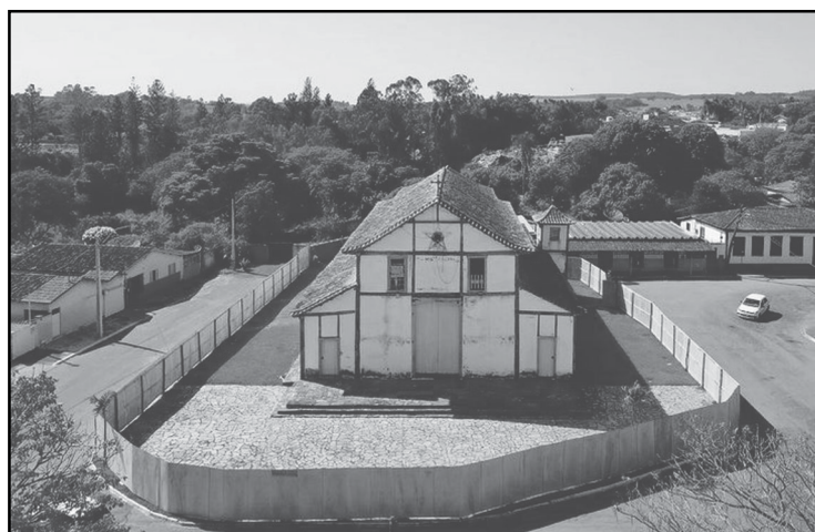
Obra de restauração está adiantada
