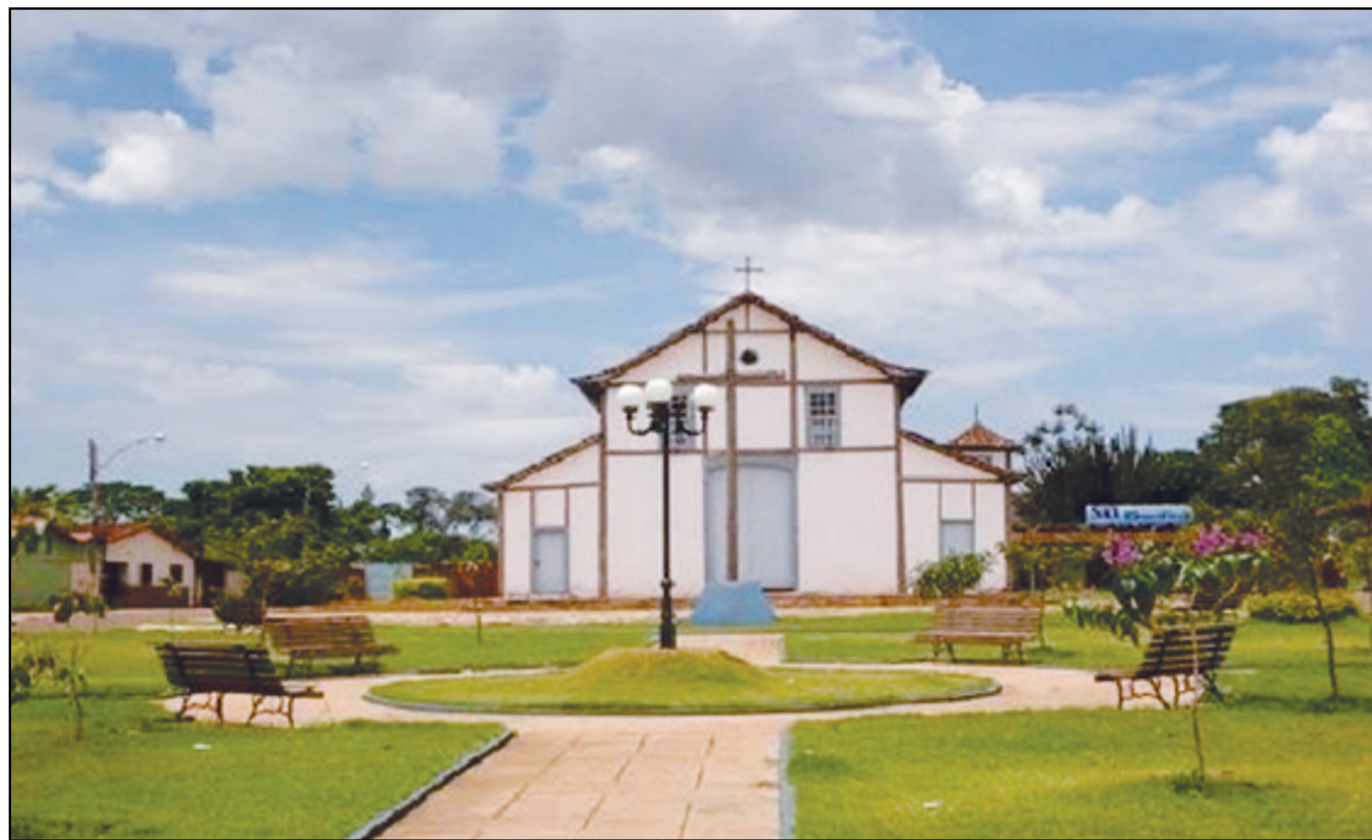
Reivindicação antiga de moradores de Silvânia, a Igreja do Bonfim vai finalmente ser restaurada
