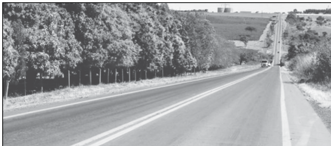
O trecho da rodovia GO-010 já está totalmente restaurado, proporcionando mais segurança e conforto aos motoristas
