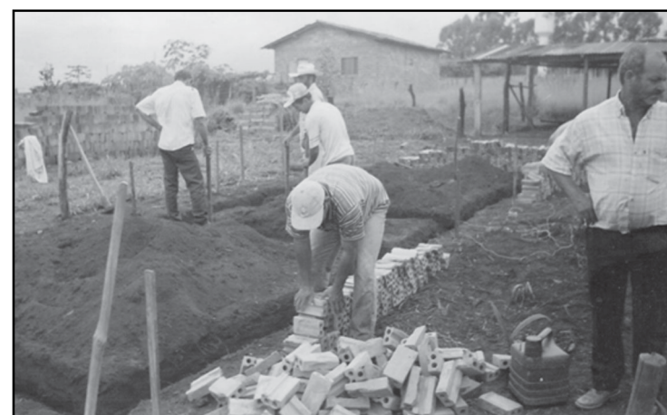
Construção da primeira casa da Pastoral da Moradia de Silvânia
