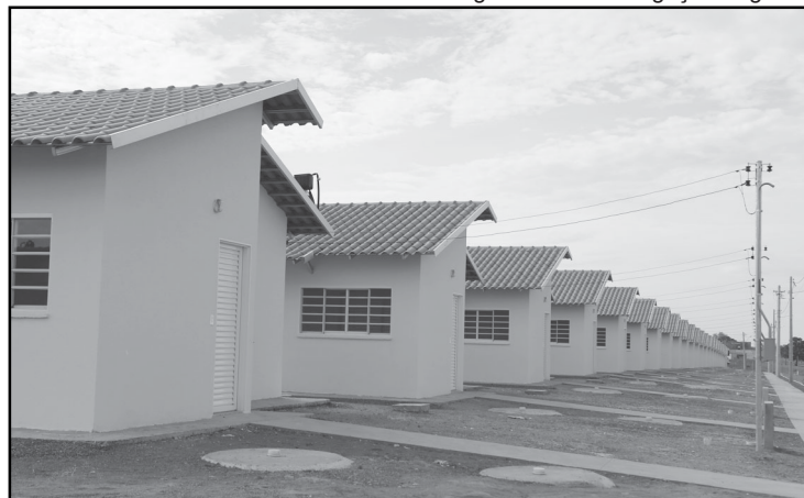
Moradias construídas pela Agehab no Município de Porangatu
