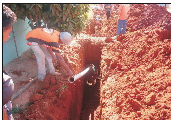
Rede de Esgoto Sanitário no Maria de Lourdes.
