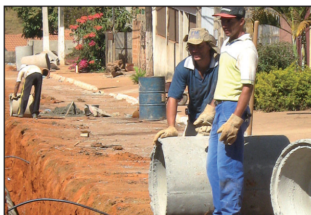
Construção de Galeria Pluvial no N. Sra. de Fátima.
