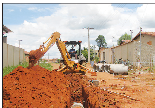
Construção de Galeria Pluvial no Maria de Lourdes.
