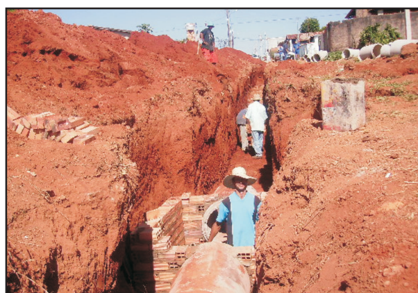
Construção de Galeria Pluvial no Park Anchieta.
