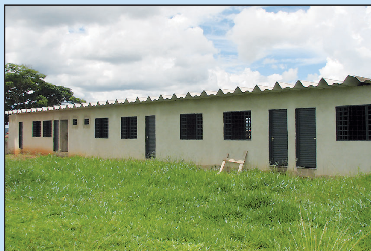
Reforma do Atenas Clube em fase adiantada.
