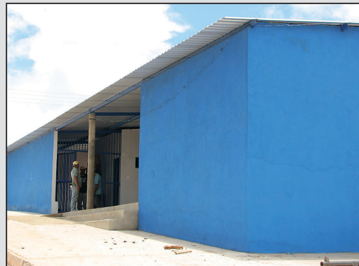
Fachada principal do campo de futebol em fase final de construção.
