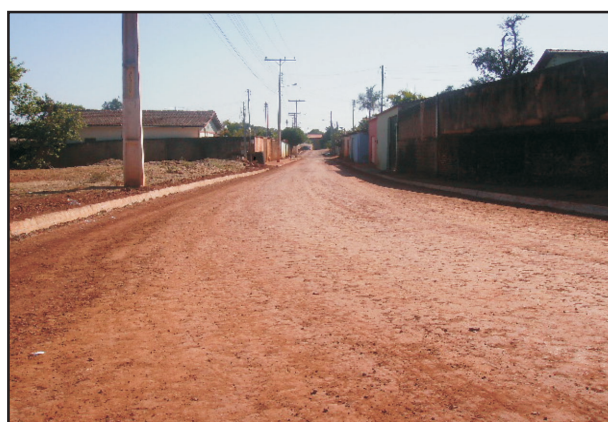
Recapeamento asfáltico no Bairro Baú.
