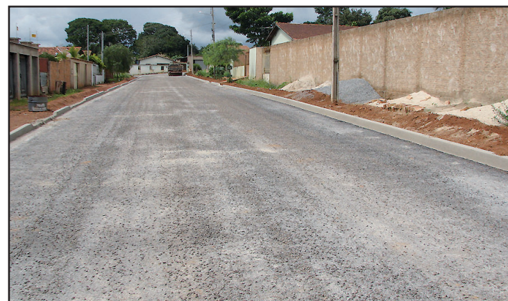
Asfalto no Residencial Jorge Barroso.
