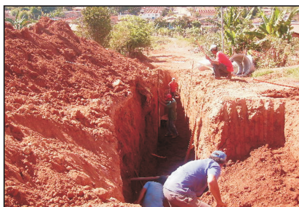
Construção de Galeria Pluvial no Santo Antônio.
