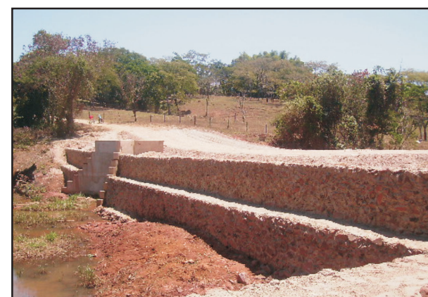
Passagem entre o Deco Correa e o Maria de Lourdes.
