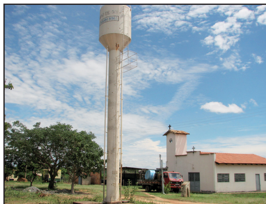
A Comunidade Quilombola de nosso município receberá água tratada em suas casas.
