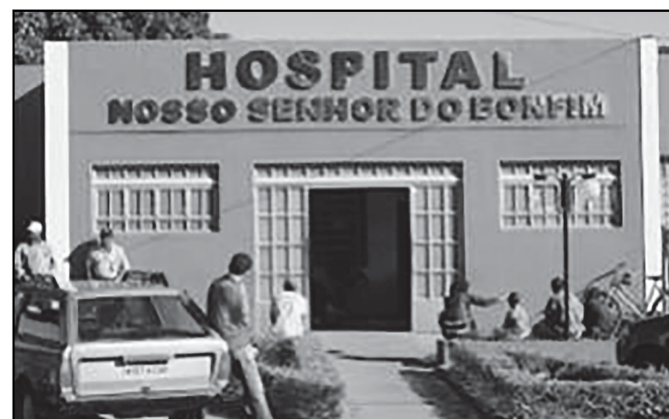
De acordo com a empresa, as obras de reforma do hospital devem ser retomadas no dia 26 e deverão ser entregues dentro do prazo
