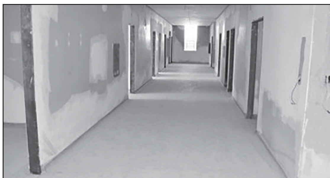
Após notificações não atendidas, a prefeitura rescindiu o contrato com a empresa que fazia a reforma do Hospital
