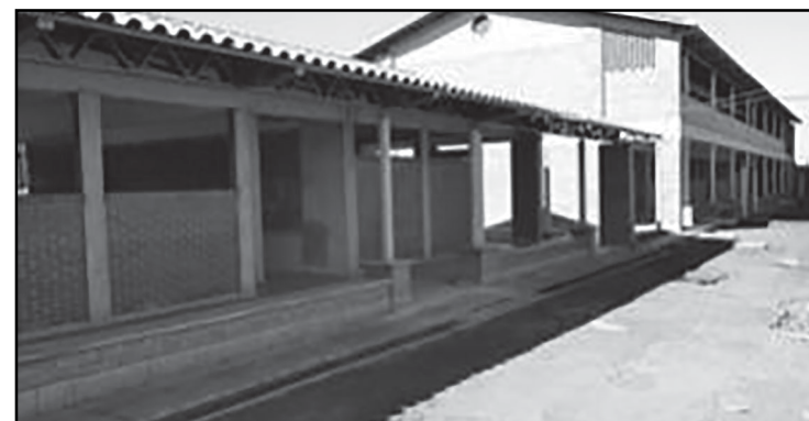
Unidade em construção em Silvânia: obras encontram-se paralisadas
