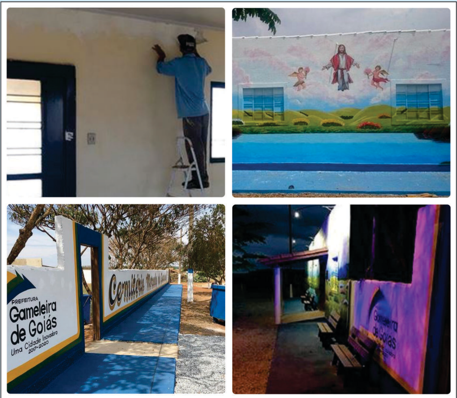
O Cemitério Municipal “Morada da Saudade”, no Distrito do Mocambinho, foi todo reformado e recebeu belíssima iluminação e um painel na fachada
