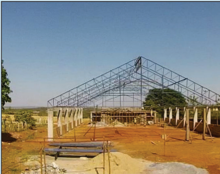
Obra do novo Ginásio de Esportes em fase adiantada
