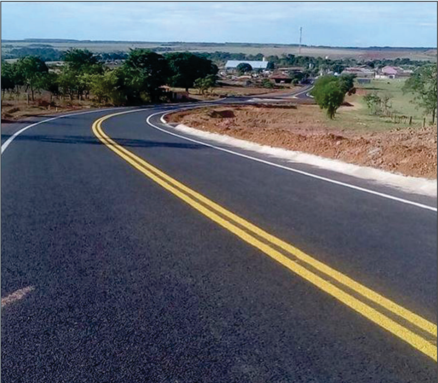
Interligação por asfalto já é uma realidade em Gameleira de Goiás. As obras da GO-437, trecho entre Silvânia e Gameleira, foram totalmente concluídas. A sinalização também já está pronta e em breve a rodovia será inaugurada
