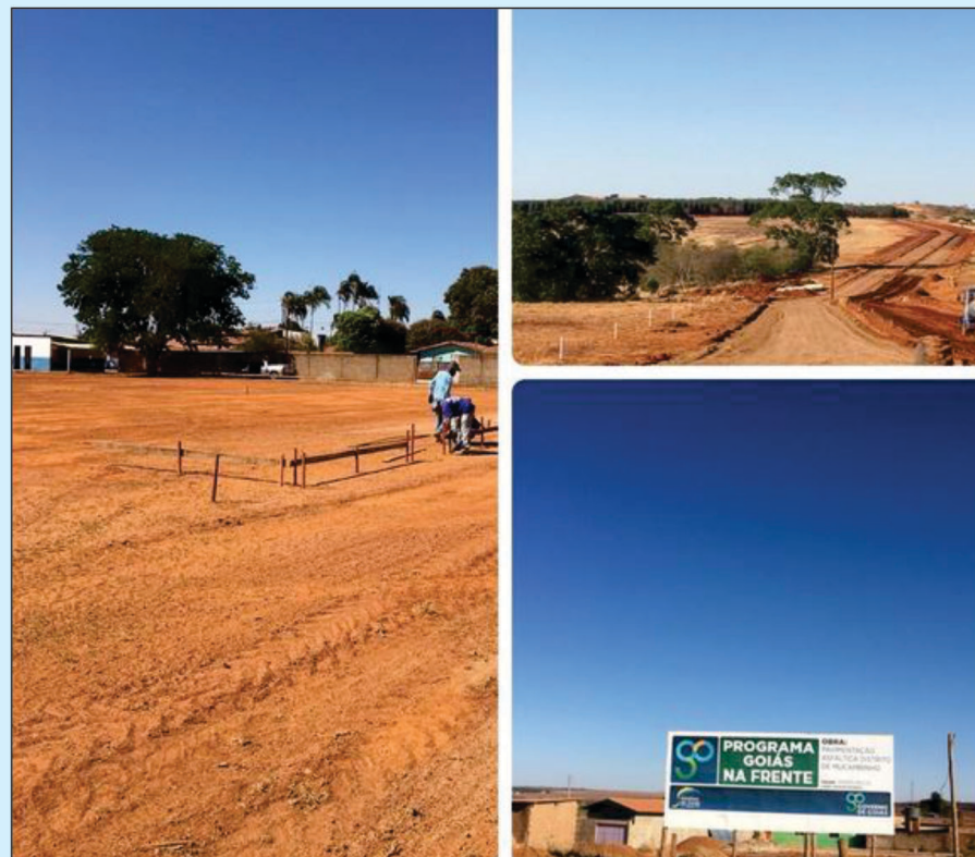
Gameleira está a todo vapor. Tanto a Prefeitura Municipal quanto a iniciativa privada estão com obras por todo o Município
