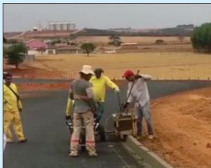
Gameleira totalmente interligada por asfalto. Obras da GO-437 em fase final
