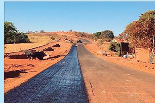
Asfaltamento da rodovia GO 437 em fase final. Em breve a obra será entregue à população
