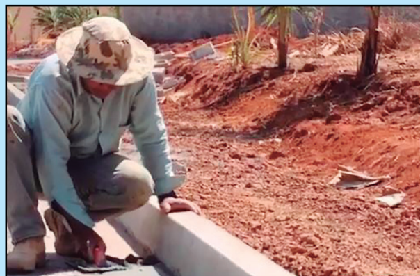
A pavimentação asfáltica no Distrito de Mocambinho foi realizada com recursos do Goiás na Frente . No detalhe, serviço de finalização de meio-fio
