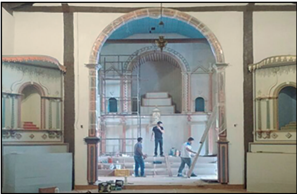
Restauração finalizada em 2017: mais de 2 anos de trabalho
