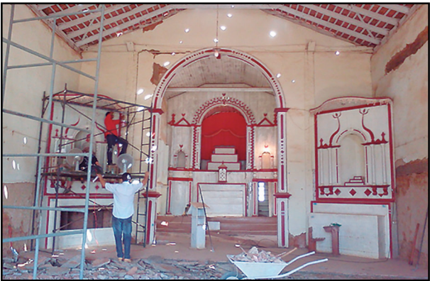
Os altars no interior da Igreja no início da restauração
