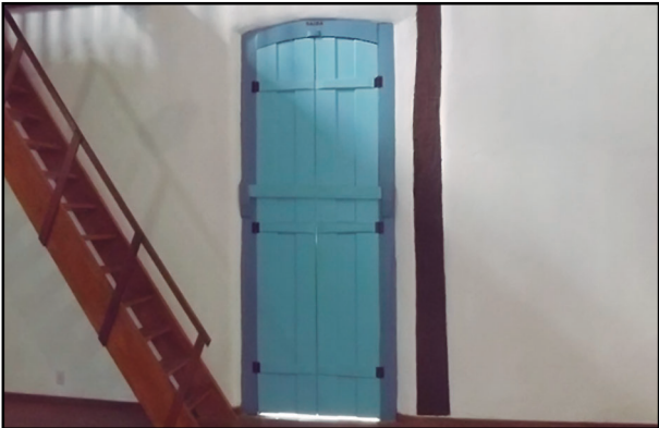
Porta principal e escada para o sótão, vista de dentro
