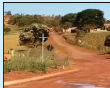
Trecho da GO 437, em conclusão, está sendo aguçado diariamente
