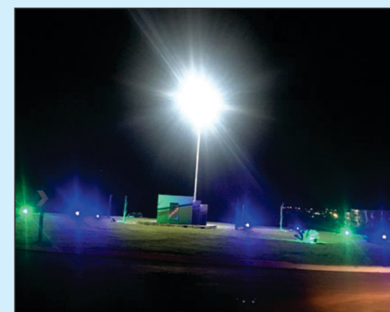
Rotatória, acesso à cidade para quem chega por Anápolis, renovada
