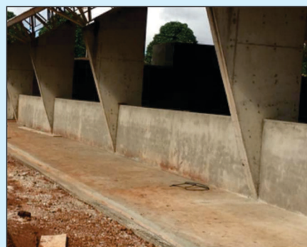
Construção da Quadra foi retomada e deve ser entregue no mês de junho
