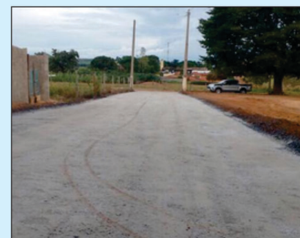
Asfalto novo executado pela atual Administração Municipal
