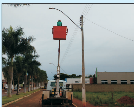
Troca das lâmpadas da iluminação pública em Gameleira e Mocambinho
