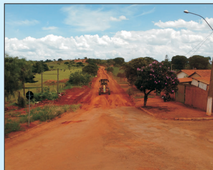
Patrolamento e encascalhamento de estrada da entrada da cidade
