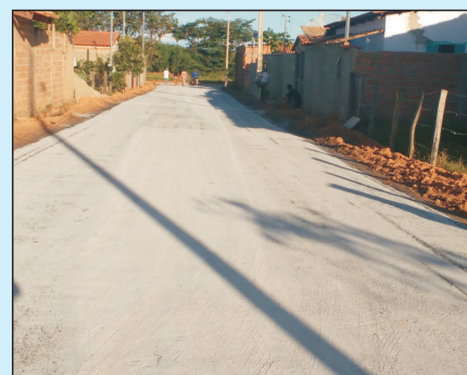
Asfalto novo executado com recursos próprios do Município
