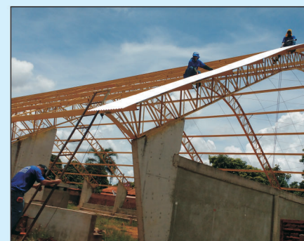
Retomada da construção do Ginásio de Esportes pelo Estado
