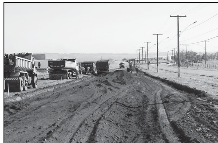
As obras de duplicação da GO 139 seguem em ritmo acelerado
