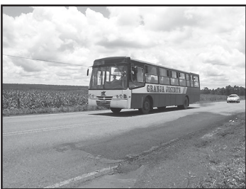
Parte do trecho da GO-010 recuperado pela empresa
