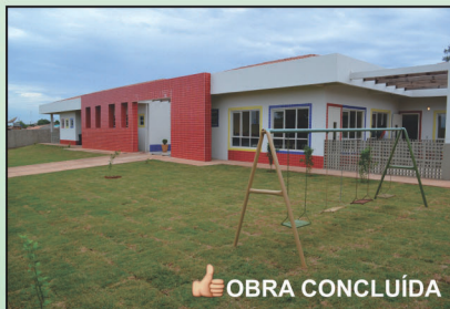
OBRA CONCLUÍDA Retomada da obra do CMEI Pe. Januário no Bairro de Lourdes
