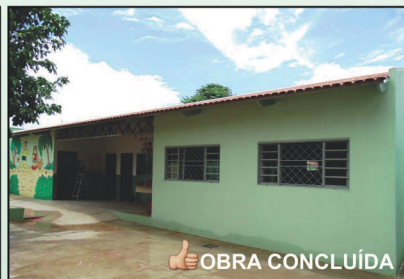
OBRA CONCLUÍDA Ampliação do CMEI Maria Teresa Bairro Nsa. Sra. de Fátima
