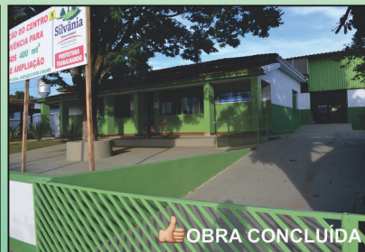
OBRA CONCLUÍDA Ampliação, reforma e implantação do centro de convivência do idoso
