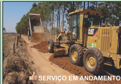
SERVIÇO EM ANDAMENTO Patrolamento e encascalhamento de estradas rurais
