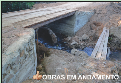
OBRAS EM ANDAMENTO Construção de pontes em diversas regiões rurais
