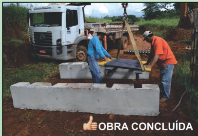
OBRA CONCLUÍDA Construção de 32 mata-burros em estradas do transporte escolar
