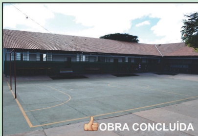
OBRA CONCLUÍDA Ampliação e reforma da Escola "Geraldo Napoleão"
