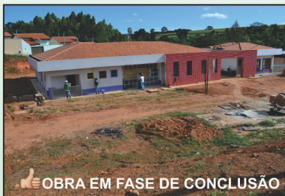
OBRA EM FASE DE CONCLUSÃO Retomada da obra do CMEI Residencial Anhanguera
