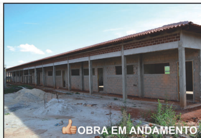
OBRA EM ANDAMENTO Escola de 6 salas padrão FNDE S. Leonides Cotrim / Setor Sul
