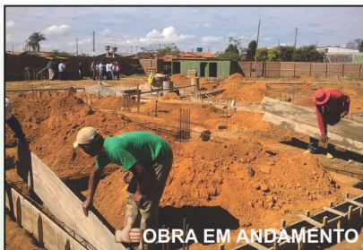
OBRA EM ANDAMENTO Escola de 6 salas padrão FNDE Distr. Cruzeiro do Bom Jardim
