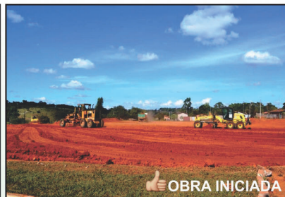
OBRA INICIADA Escola de 12 salas padrão FNDE Setor São Sebastião
