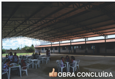
OBRA CONCLUÍDA Cobertura para espaço multi-uso Distr. Cruzeiro do Bom Jardim
