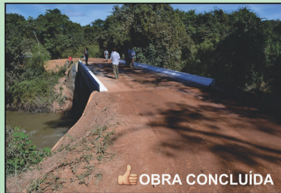
OBRA CONCLUÍDA Ponte sobre o Rio Piracanjuba Construída em parceria com a Prefeitura de Vianópolis
