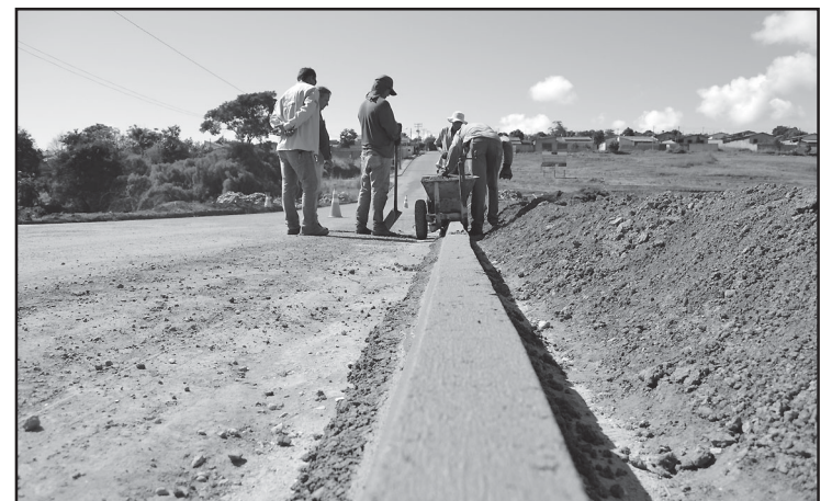
Meio-fio sendo construído na via que liga os bairros Maria de Lourdes e Jorge Barroso
