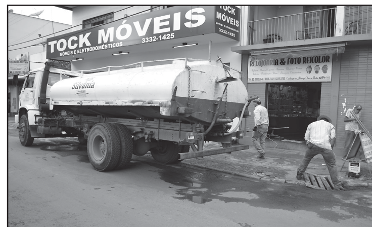
Equipe realizando o desentupimento de bueiro na Mário Ferreira
