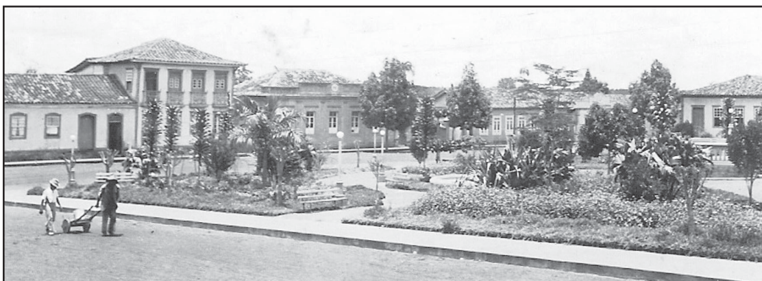
Sobrado do Coronel Chiquinho (à esquerda), pai de Henrique Silva e onde viveu antes de ir para o Rio de Janeiro estudar. Foi demolido para a construção da Prefeitura Municipal. Foto do Livro de Cida Sanches: Silvânia em Foco: Documentário histórico fotográfico
