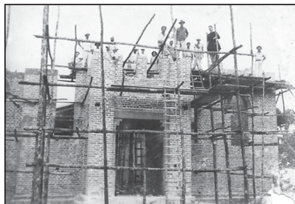
Construção da Matriz de Leopoldo de Bulhões.
