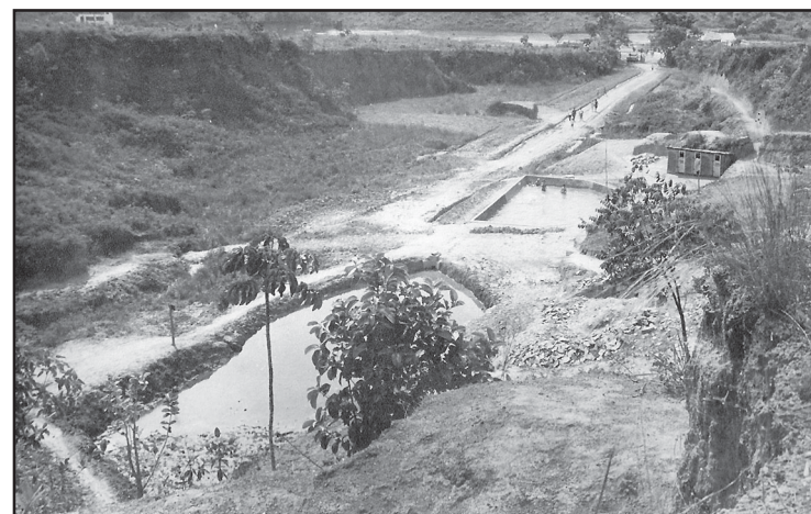
Construção das represas no Bairro Pedrinhas em 1963. Foto: Acervo Alessandra Nascimento.
