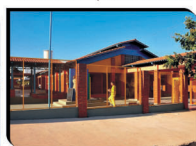
CONSTRUÇÃO DE ESCOLA PADRÃO FNDE SÉCULO XXI DO BAIRRO SÃO SEBASTIÃO R$ 3,8 MILHÕES - GOV. FEDERAL
