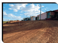
PAVIMENTAÇÃO DE RUAS DOS BAIROS PEDRINHAS E JORGE BARRIOS - R$ 539 MIL - GOV. FEDERAL
