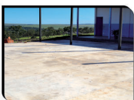
CONSTRUÇÃO DE QUADRA COBERTA NA ESCOLA ALEXANDRINA PEREIRA R$ 60 MIL - GOV. ESTADUAL
