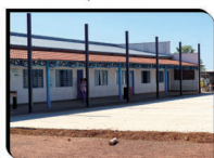
CONSTRUÇÃO DE QUADRA COBERTA NA ESCOLA JOSÉ EDUARDO MENDONÇA R$ 60 MIL - GOV. ESTADUAL
