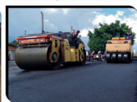
120 MIL METROS DE RECAPEAMENTO ASFÁLTICO - R$ 1,5 MILHÃO - GOV. ESTADUAL
