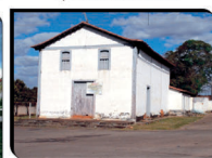
RESTAURAÇÃO DA IGREJA DE SÃO SEBASTIÃO R$ 753 MIL - GOV. ESTADUAL
