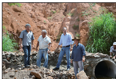
Barragem no Bairro Santo Antônio está sendo recuperada.
