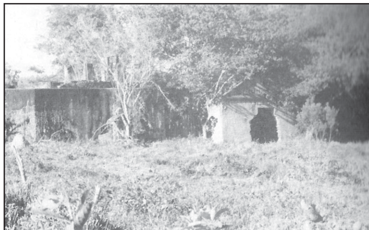
Ruínas da Usininha, no Rio Piracanjuba, que forneceu energia para Silvânia até 1966. Foto do livro Silvânia: Enredo e Personagens , de Edmar Cotrim.
