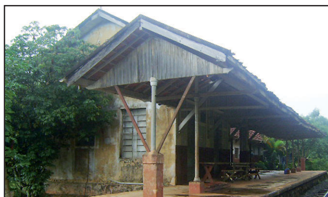
Estação Ferroviária de Silvânia será restaurada.
