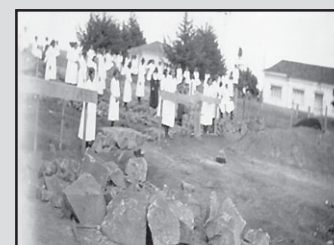
Construção do colégio. Ao fundo o Hospital.
