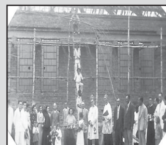
Colocação da primeira telha do Instituto Auxiliadora 20 de outubro de 1936.
