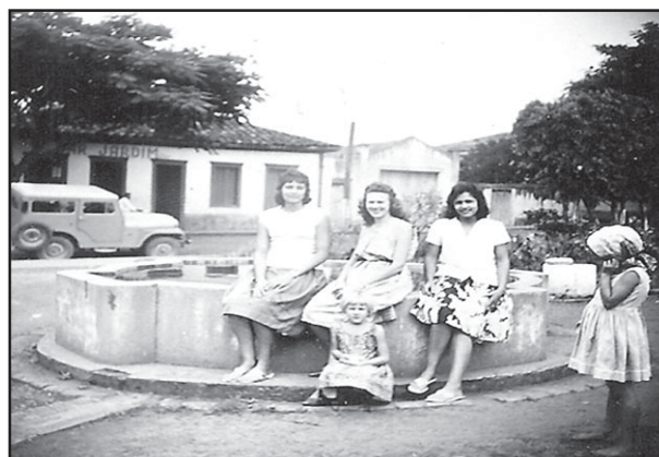
Reservatório de água destinado ao consumo da população na Praça do Rosário. Data desconhecida.
