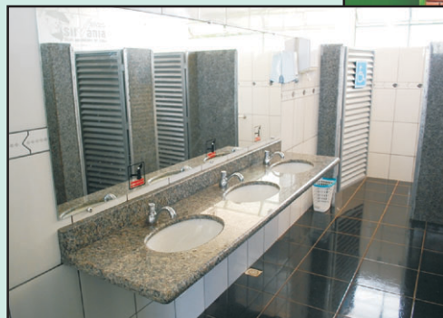
Vista parcial das melhorias nos sanitários.
