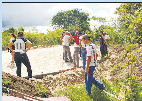
Alunos inspecionam as técnicas de montagem e funcionamento das “Caixas de Areia”, dentro das normas exigidas
