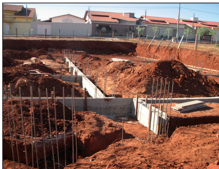
Obras de construção já foram iniciadas.
