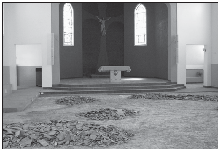
O piso da Matriz foi totalmente removido na obra de reforma.
