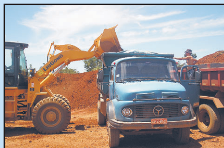
Colaboradores da AMASIL conduzindo máquinas e caminhões de seus associados.
