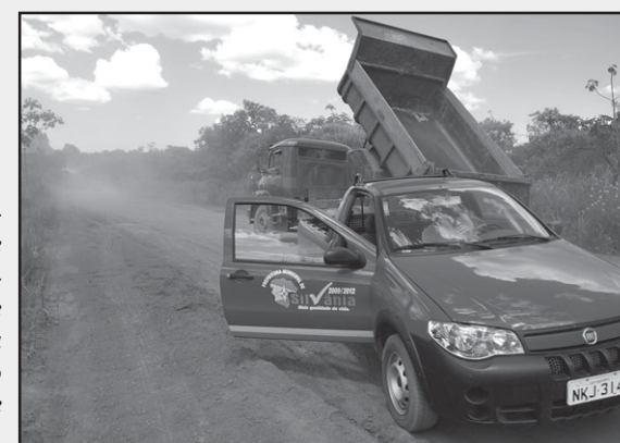
Encascalhamento e patrolamento de estradas na região do João de Deus.
