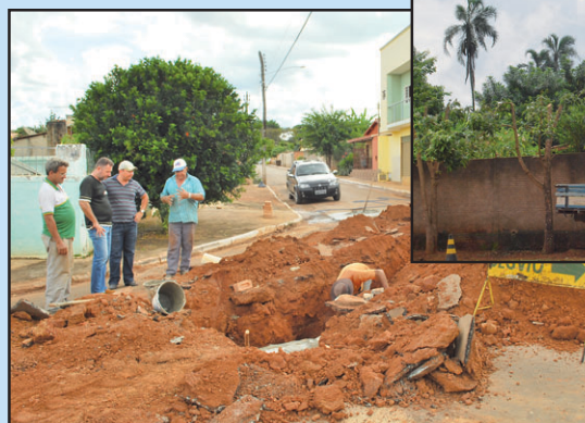
Ao lado, construção de galeria pluvial e acima a instalação de postes de iluminação pública.
