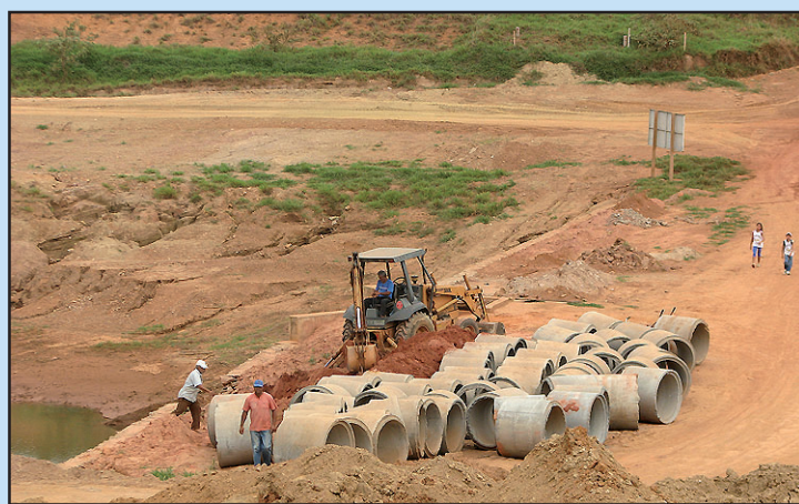
Galerias pluviais: infra-estrutura para receber o asfalto.
