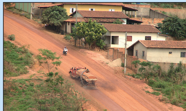
Pavimentação asfáltica no Bairro Maria de Lourdes.
