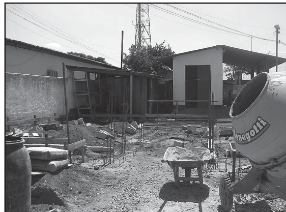
Obra da nova sede da Saneago já está em andamento.
