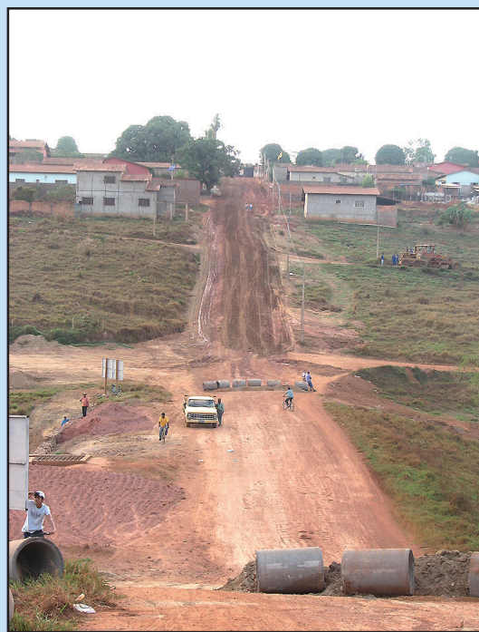
Terraplanagem iniciada no Maria de Lourdes.
