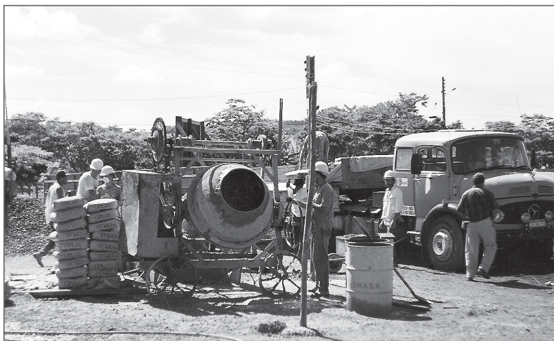
Canteiro de obras da UEG em Silvânia: esforços recompensados.
