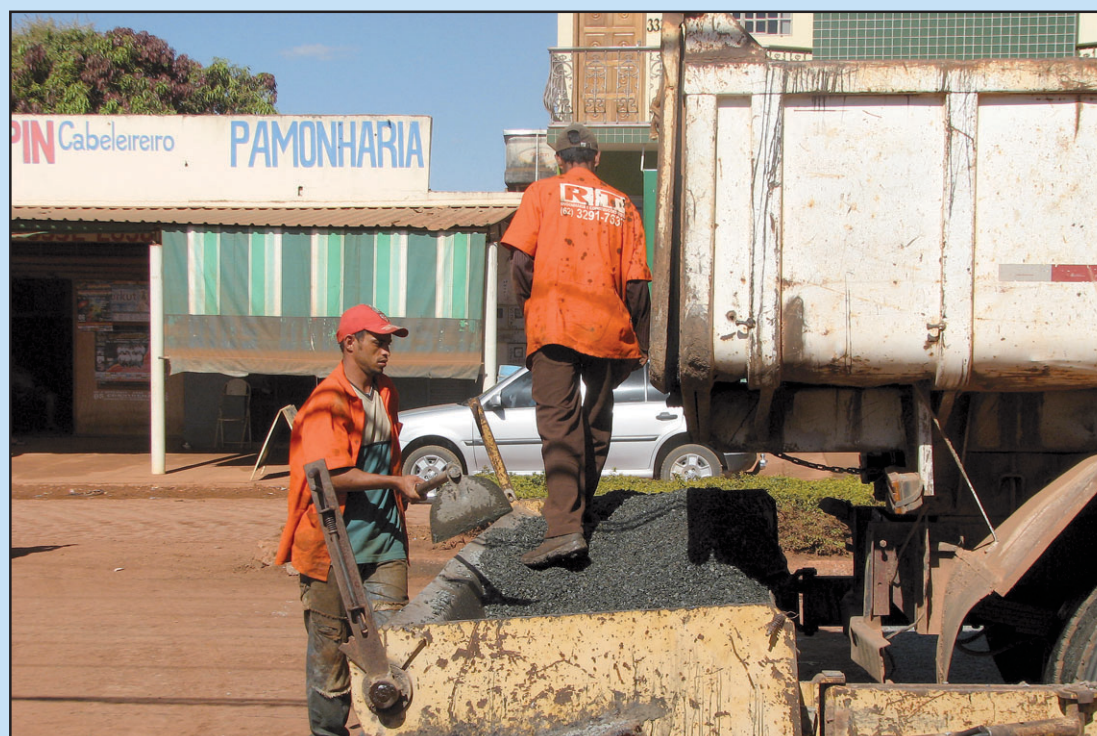
Asfaltamento da avenida Dom Bosco, em fase final de conclusão.
