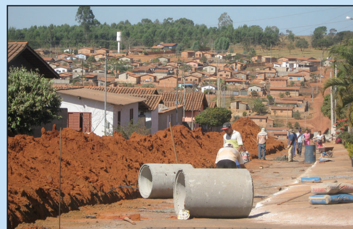
Em breve o Bairro Maria de Lourdes receberá galerias pluviais.
