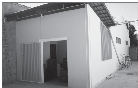
... em fase final de reforma: benefício ao produtor.
