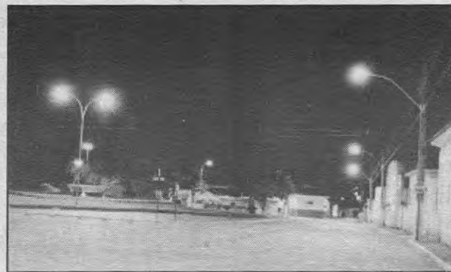
A Prefeitura de Silvânia instalou cerca de cem novas luminárias nas praças de nossa cidade, proporcionando uma nova iluminação mais bonita e eficiente.
