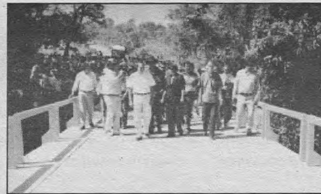
Grande concentração popular durante a inauguração da ponte sobre o Rio dos Patos. A obra foi realizada com recursos do PRONAF e complementados em grande parte pela Prefeitura Municipal.
