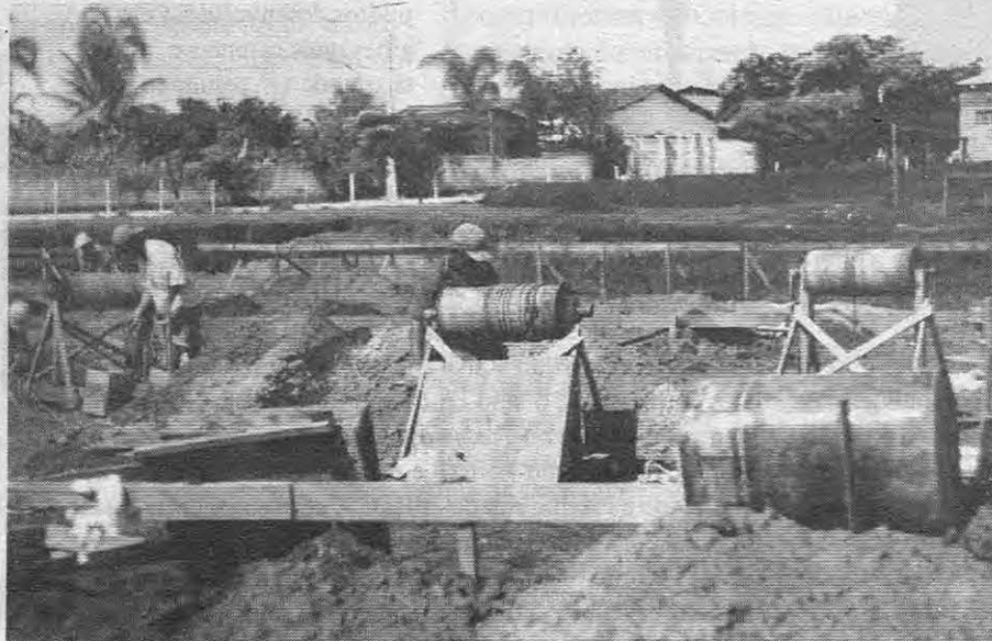
Canteiro de obras da Faculdade: em breve, as paredes estarão sendo erguidas.
