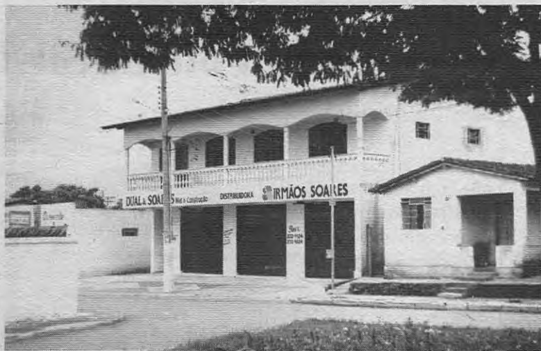
A fachada da nova empresa de materiais para construção - DUAL.
