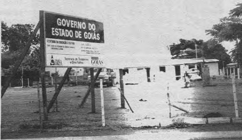
As obras de construção da Faculdade já começaram.
