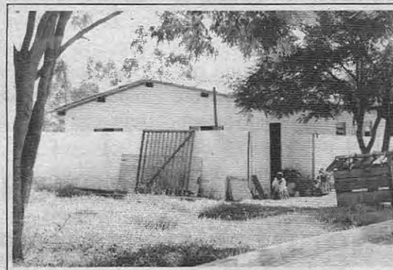
Casa do zelador do Parque: mais conforto.
